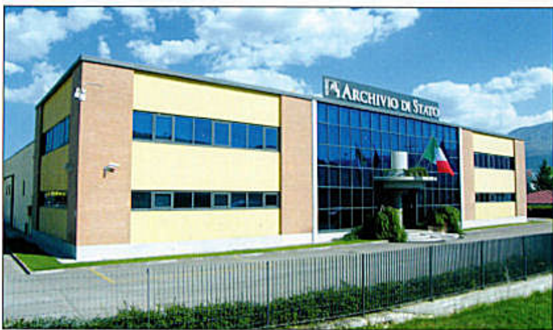
La nuova sede dell'Archivio di Stato dell'Aquila a Bazzano.
